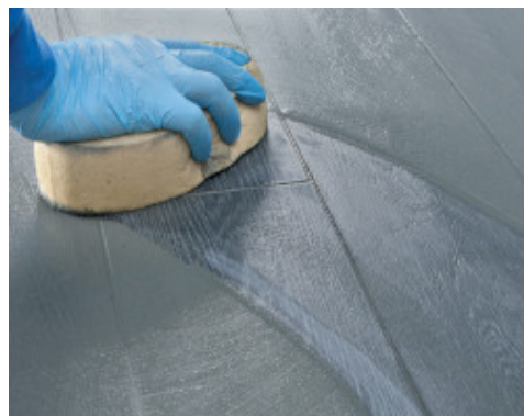
Čišćenje i završna obrada fuga tvrdom celuloznom spužvom
