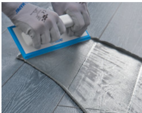
Nanošenje Ultracolor-a Plus na gresporculanske pločice s efektom drveta gumiranom gladilicom
