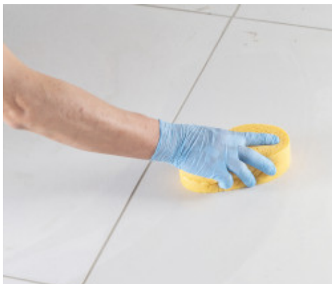
Čišćenje i završna obrada fuga tvrdom celuloznom spužvom
