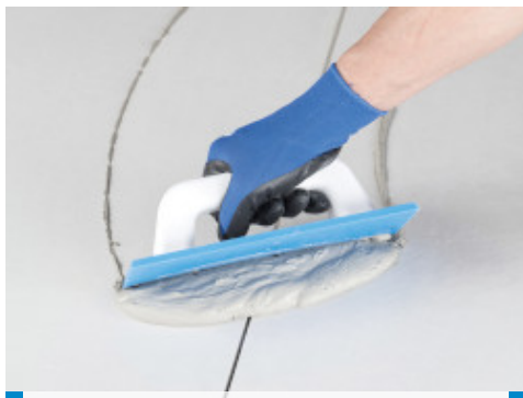
Nanošenje Ultracolor-a Plus na gresporculanske podne pločice s efektom mramora gumenom gladilicom
