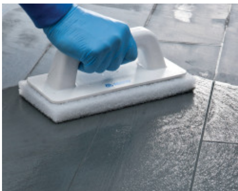
Čišćenje fuga ScotchBrite® spužvom (kad je proizvod polutvrd)
