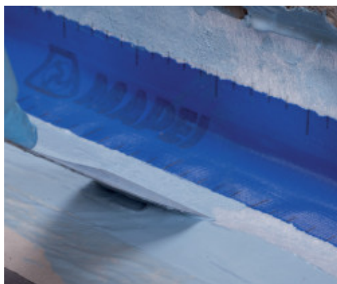
Ugradnja Mapeband-a u Mapelastick AquaDefense na spoju pod-zid
