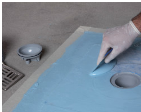
Nanošenje Mapelastick-a AquaDefense na manžetu odvoda Drain Vertical
