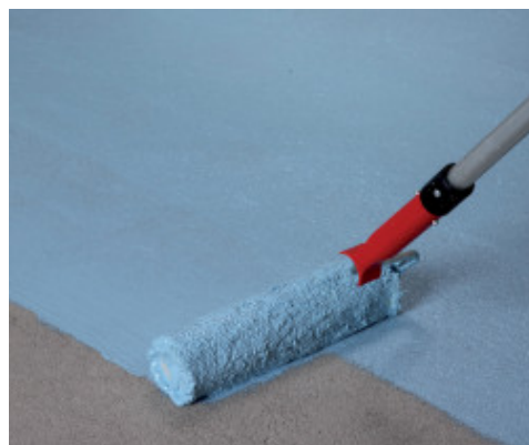
Nanošenje prvog sloja Mapelastick AquaDefense na estrih
