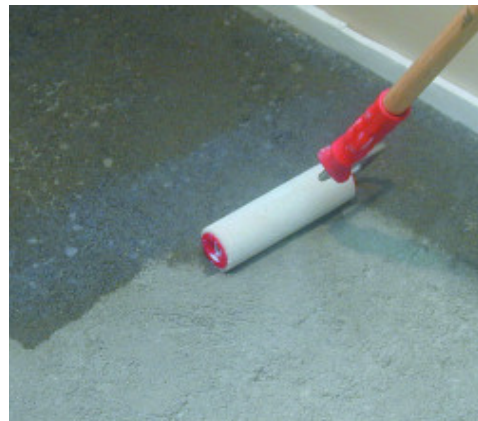
Nanošenje Primer-a G sa valjkom
